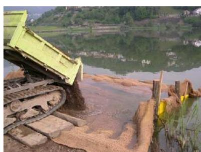
Preparazione del letto di posa attraverso il riempimento di stuoie in cocco con materiale di scavo.
