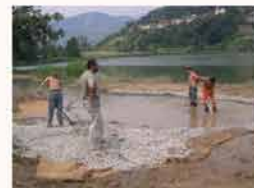
Posa sul fondo di un substrato di materiale alluvionale grossolano.
