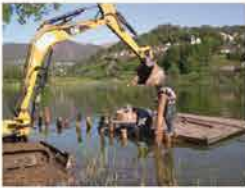
Posa di fascine sommerse per consolidare la riva, limitare l'erosione e contenere l'effetto del moto ondoso
