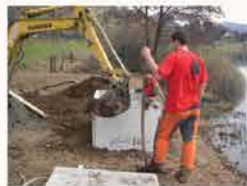
Riempimento mediante miscela di sabbia, limo e argilla in differenti proporzioni
