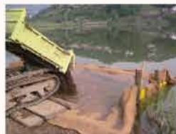
Preparazione del letto di posa attraverso il riempimento di stucchi in cocco con materiale di scavo.
