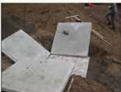
Messa in opera degli elementi della struttura realizzati in calcestruzzo prefabbricato
