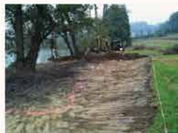
Preparazione dell'area di intervento mediante scarifica superficiale e delimitazione dell'area di scavo in falda
